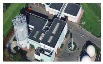
Los sistemas de metanización consisten en la degradación biológica anaerobia (sin oxígeno) de la materia orgánica. En el proceso se produce un gas combustible comúnmente denominado biogás, constituido mayoritariamente por metano y dióxido de carbono, con vestigios de gas sulfhídrico, N2, O2, H2, entre otros.
